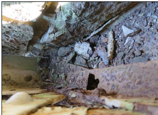
K01 - příčné ztužení č. 3 vlevo, dolní pas koroze
