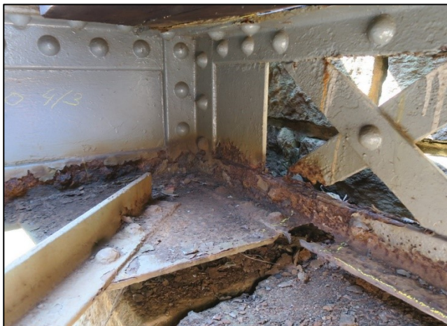
K01 - styčnický příčný a podélný ztužení č. 3 / hlavní nosník vlevo - korozní oslabení
