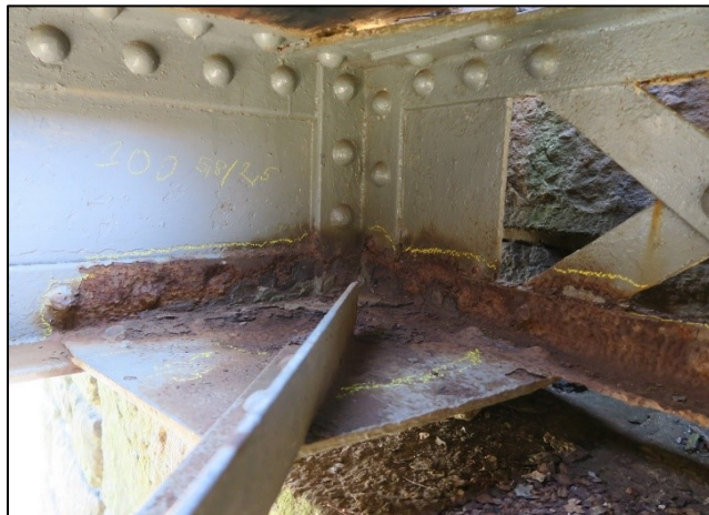
K01 - styčnický příčný a podélný ztužení č. 1 / hlavní nosník vpravo - korozní oslabení
